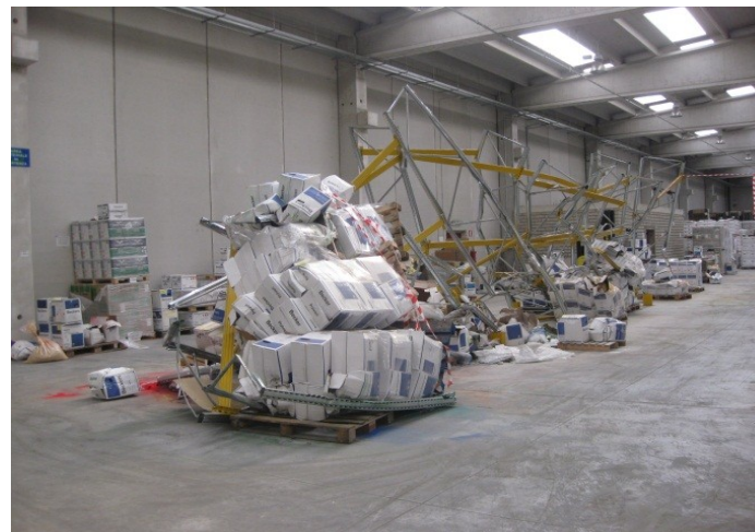
Collasso di scaffalatura porta pallet – terremoto Aquila
